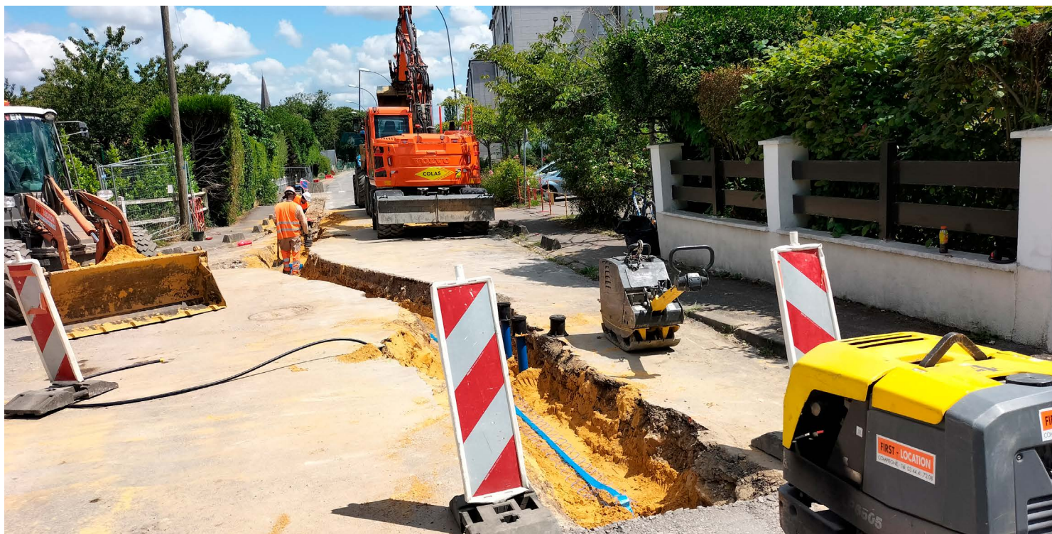
Travaux rue Notre-Dame de Bon Secours
