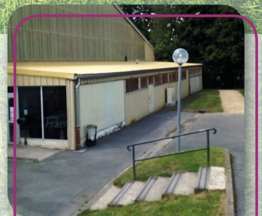
Toiture du club house du tennis couvert
