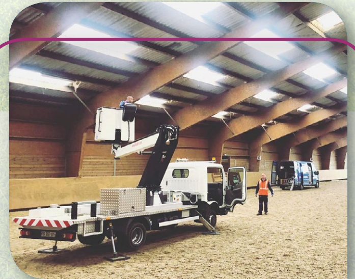
Changement des éclairages du centre équestre, manège et écuries
