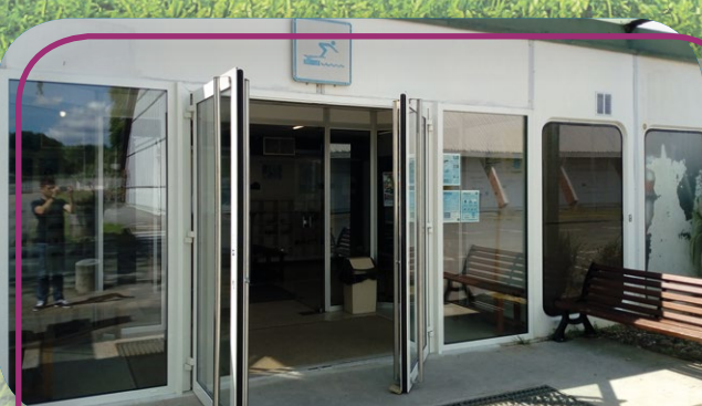
Restauration des portes de la piscine Yves Carlier
