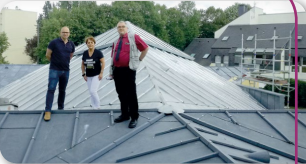
Réfection de la verrière de l'école maternelle d'Orion
