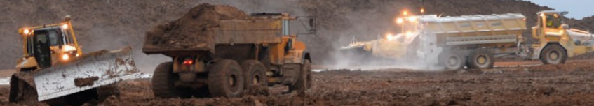
Le chantier de plateforme logistique de la Société Goodman redessine le « parc des Portes de Senlis »
